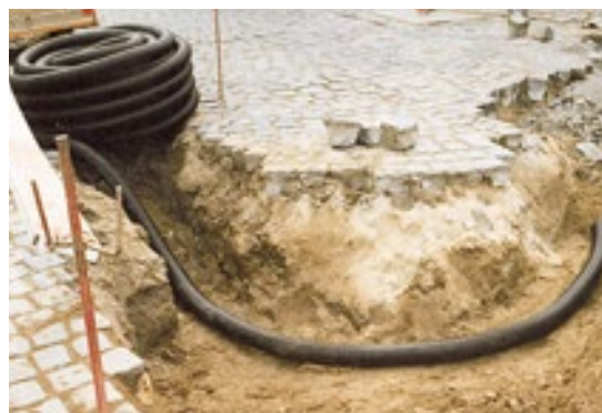
Kabuflex R en Kabuflex R-UV – voordeel bij ontoegankelijk terrein en een hobbelige ondergrond
